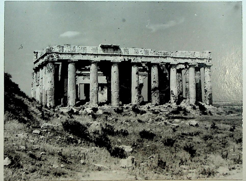
4. Керчь. Коробка здания исторического музея на горе Митридат.
