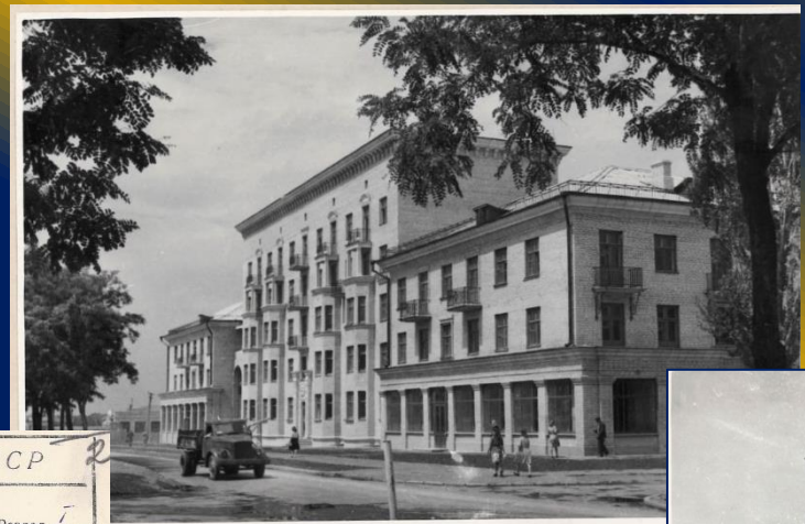
Днепропеталь /подрядчик трест Запорожстрой, 1 жил.дом в 2-3 этаж - 12762 кв.м. принята 1950 ект Харьк. гор арх. Вег Принят 30 а/ Вид б/ Вид в/ Вид
