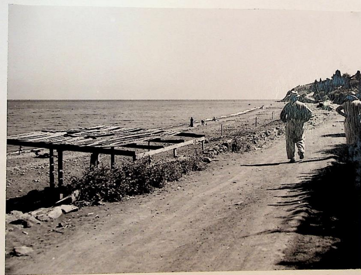
40. Гурзуф. Набережная и продолжение городского пляжа. Полное отсутствие благоустройства.
