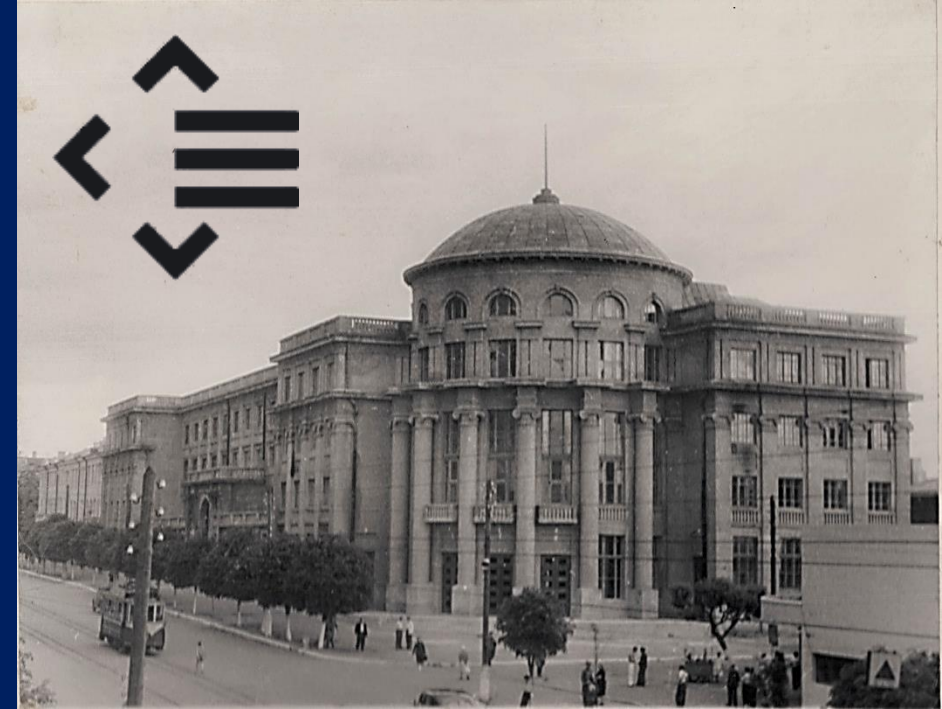
Місто Вінниця. Відновлення будинку обкому КП(б)У. Фото 1946 р. ЦДАВО України. Ф. 4906. Оп. 2. Спр. 3. Арк. 4.
